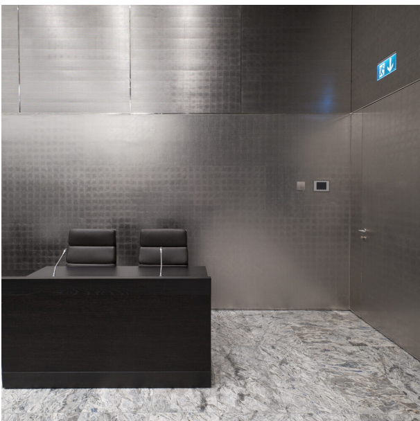
Wandverkleidungen in Aluminium nicht brennbar Integrierte Türen nach VKF und Lichtband
